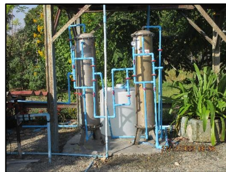
ภาพที่ 3.34 การติดตั้งเครื่องกรองน้ำบริเวณน้ำบ่อต้นบ้านช่องใต้
